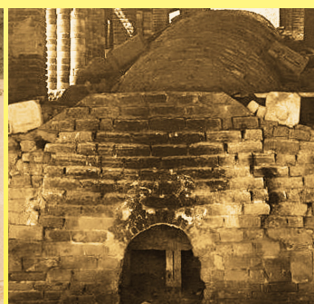
Traditionell chinesischer Drachen-Töpferofen (chinesisch 龙窑 lung-yao), Öffnung zum Beladen und Stapelmethode mit Elektroporzellan (Privatsammlung)
